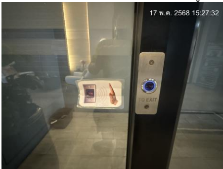
ระบบคีย์การ์ดเข้า-ออกประจำอาคาร โดยชั้นล่างบริเวณประตูทางเข้าลิฟต์
