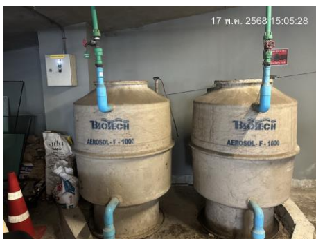
ระบบกำจัดละอองลอย (Aerosol)
