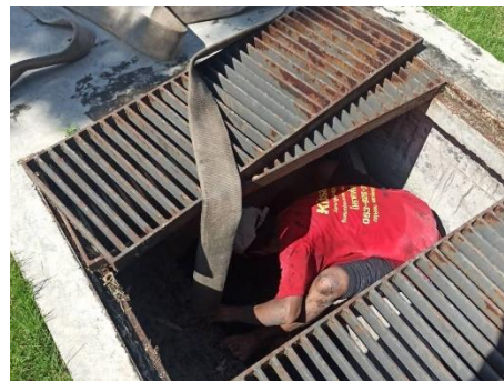
รูปที่ 2.1-10 การทำความสะอาด ขุดลอกบ่อบำบัดน้ำ บ่อดักขยะบ่อบำบัดน้ำโครงการ ระบบระบายน้ำโครงการ
