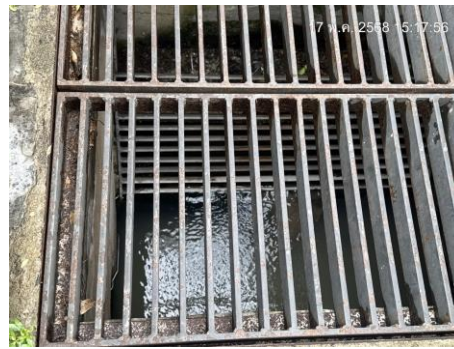
บ่อบำบัดน้ำก่อนระบายออกนอกโครงการ
